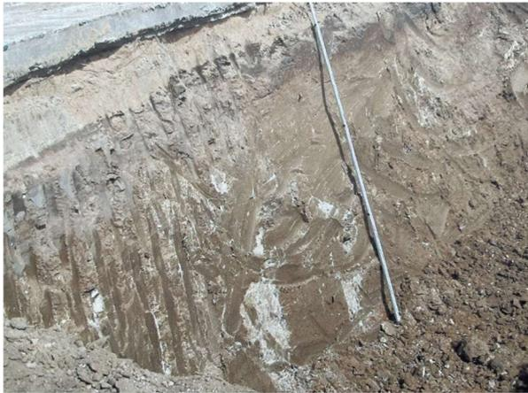
*Abbildung 3: Aufgeschlossene geologische Barriere (Mergel ca. 2,5 m) in der Baugrube des Feststoffsedimentationssystems unmittelbar südlich des wasserüberdeckten Zentralbereichs*
