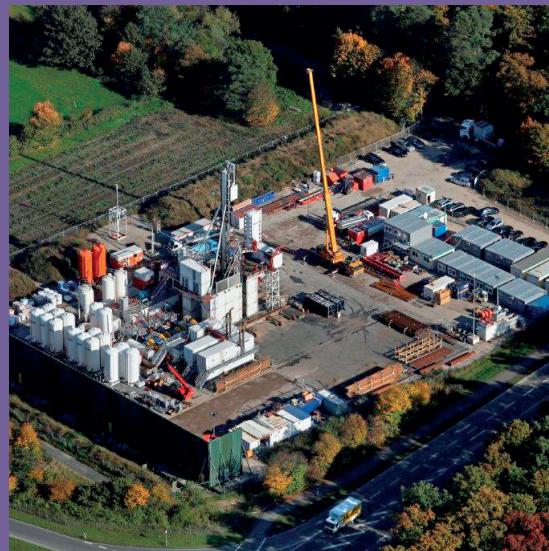
Beispiel eines Bohrplatzes während der temporären Bohrphase.
